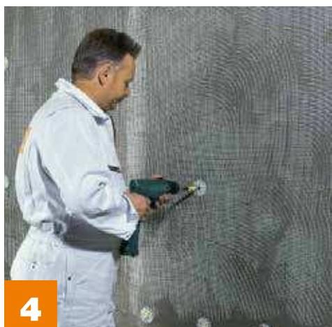
montáž kotvení šroubovacími hmoždinkami přes pancéřovou armovací tkaničku
