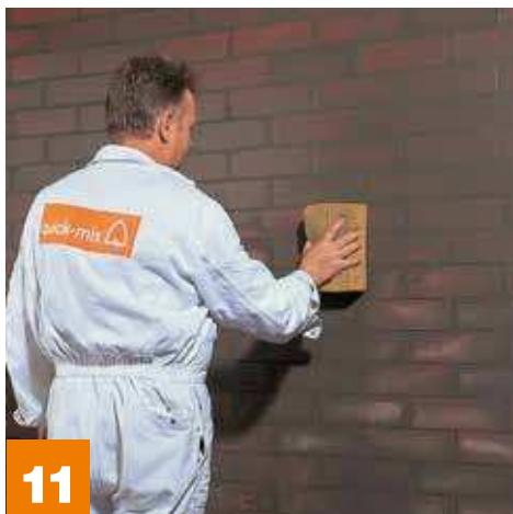
ocíštění stěny po celoplošném spárování maltou quick-mix RSS opatrným omýváním po zavadnutí malty
