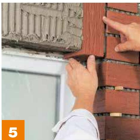
lepení cihlových pásků maltou quick-mix RKS na nadpraží stavebního otvoru
