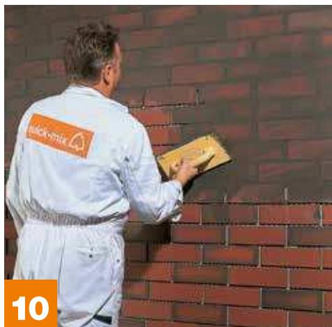
celoplošné spárování obkladu stěny s glazovaným nebo slinitým povrchem spárovací maltou quick-mix RSS
