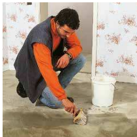
Pro vázání prachu a zlepšení přilnavosti mezi podkladem a následným potěrem nebo těsnicí maltou se celá plocha předem důkladně namočí za pomoci širokého štětce nebo kartáče.
