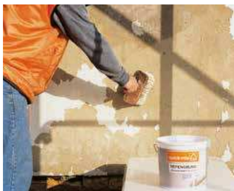
Pokud se některá místa drolí, je nutné je ošetřit produktem quick-mix MTG. Tento produkt lze nanášet širokým štětcem nebo válečkem.
