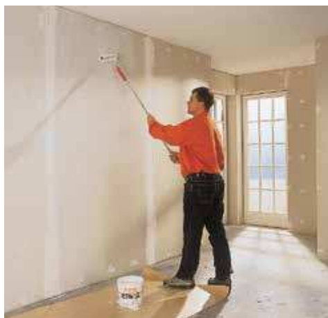
Minerální penetrace quick-mix se na celou plochu nanese malířským válečkem. Omezí se tak savost sádkartonových desek.
