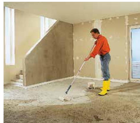
Pro následný pojený potěr se celá čištěná betonová plocha ošetří produktem quick-mix EMU.
