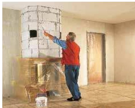
Pokud se jedná o pórobeton, který je silně savým podkladem, musí být na celou plochu nanesen základ/penetrace HAG-AS.
