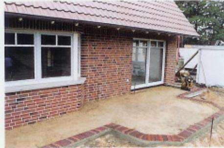
Do uzavřeného lemování se nyní uloží drť na vytvoření lože (drť o zrnitosti 0 - 5 mm). Množství použitého materiálu by mělo být stanoveno tak, aby konečná výška lože po zhutnění nebyla vyšší než 3 cm.
